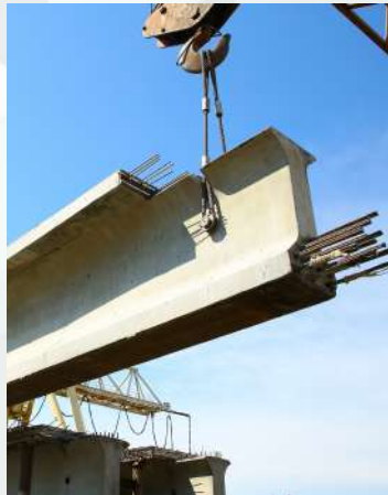
Vigas, losas, columnas y muros
