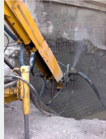
Reparación de estructuras
