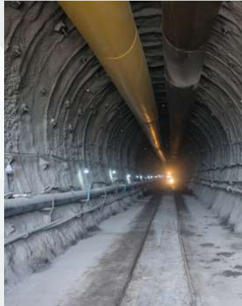
Revestimiento de túneles
