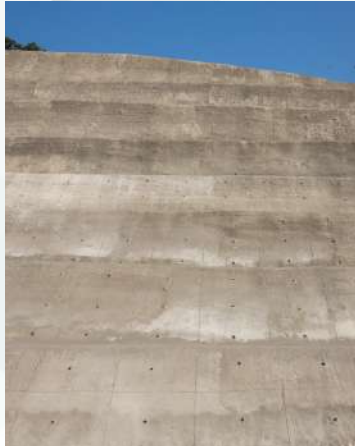
Estabilización de taludes
