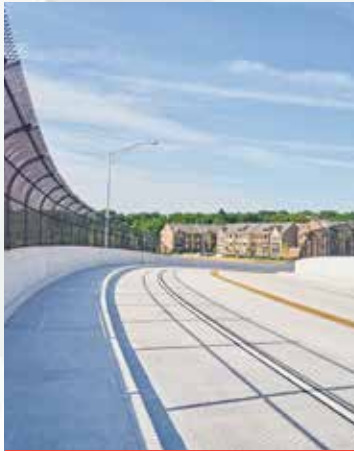
Pavimentos exteriores en obras
