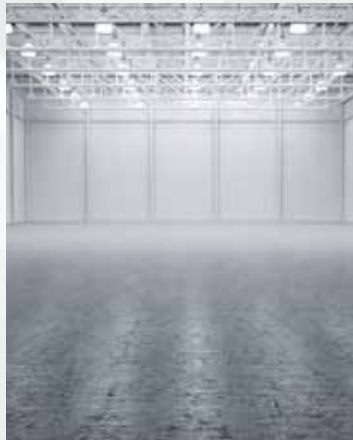
Patio de maniobras
