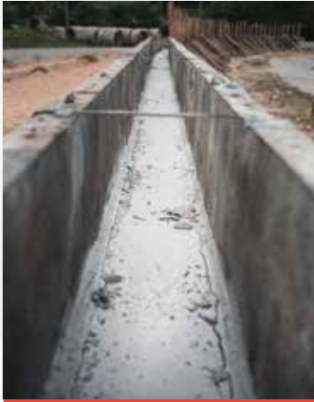
Relleno de zanjas y encofrados
